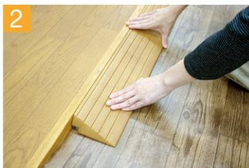
隙間がないように床面に設置。
