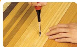
●「住宅改修」としてご使用の場合は、付属の床固定用ネジで2カ所床面に固定してご使用ください。
