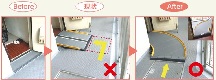
●従来のスロープだと、車いすの旋回部分が狭く、置けなかった場所にも設置でき、安心して走行できます。
